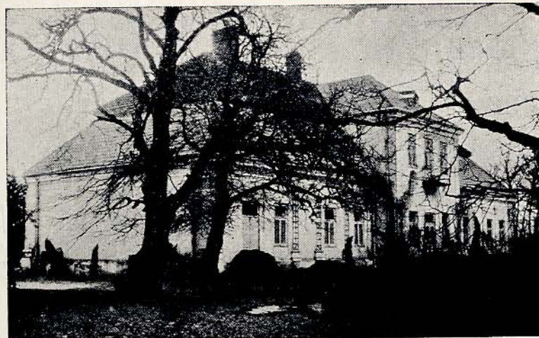
ZAMEK W SUSZNIE zbudowany w VIII w.
