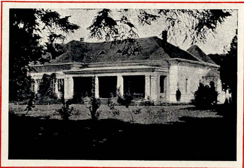
TERASA i POŁUDNIOWA STRONA DWORU W NOWYM SIOLE (budowa nowoczesna).
